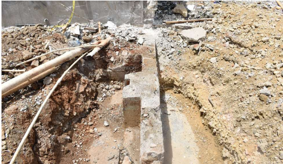
IMAGEN 28: ZAPATA DE LA COLUMNA ELIMINADA EN ESCENARIO.
