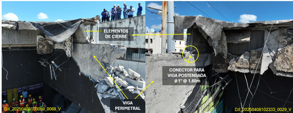
IMAGEN 26: MODELO TRIDIMENSIONAL Y FOTOGRAFÍA ELEMENTOS DE CIERRE PARA ESTABILIDAD LATERAL DE LAS VIGAS TRANSVERSALES Y FOTOGRAFÍAS.
