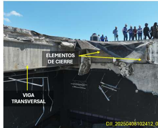
IMAGEN 25: ELEMENTO DE CIERRE PARA ESTABILIDAD LATERAL DE LAS VIGAS TRANSVERSALES
