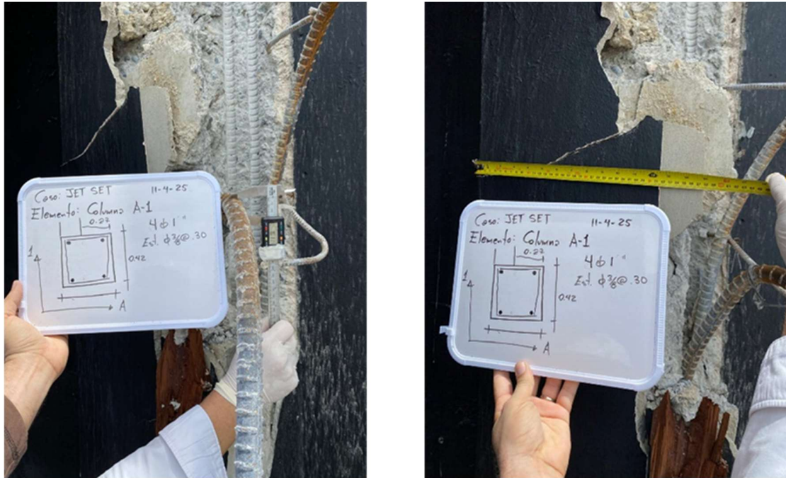
IMAGEN 22: DETALLE DE SECCIÓN DE COLUMNAS
