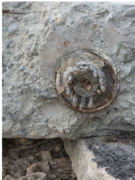
IMAGEN 36: ACERO DE CABLES DE VIGAS POSTENSADAS
