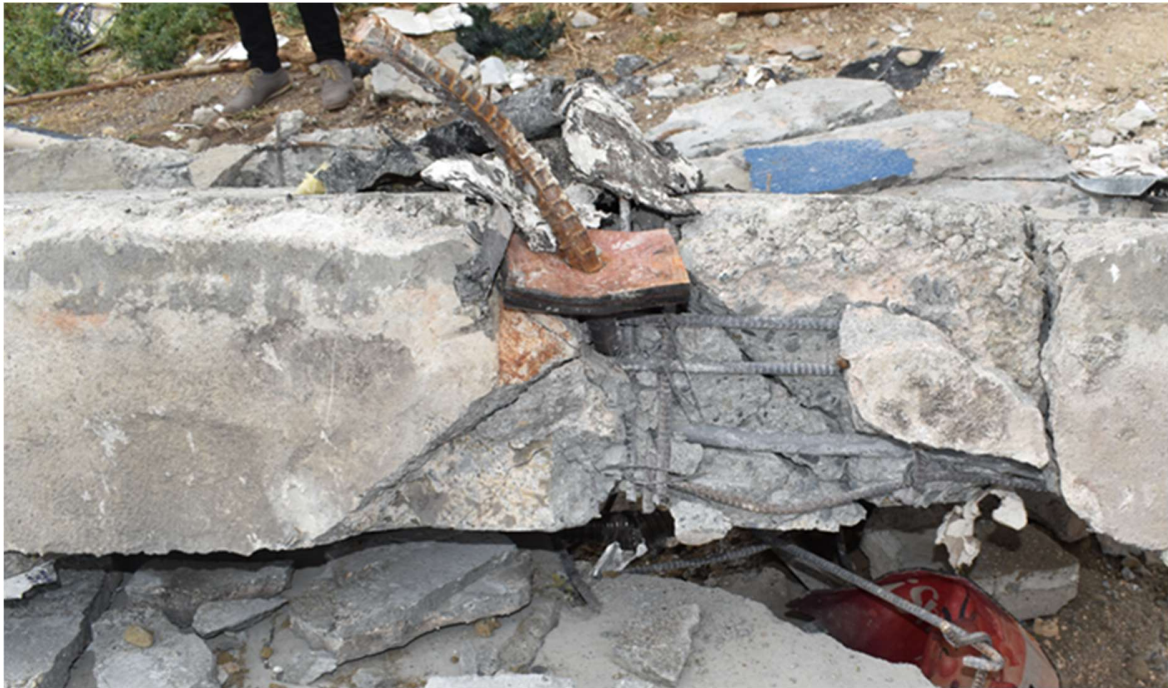
IMAGEN 23: ANCLAJE DE VIGA TRANSVERSAL A LA VIGA PERIMETRAL
